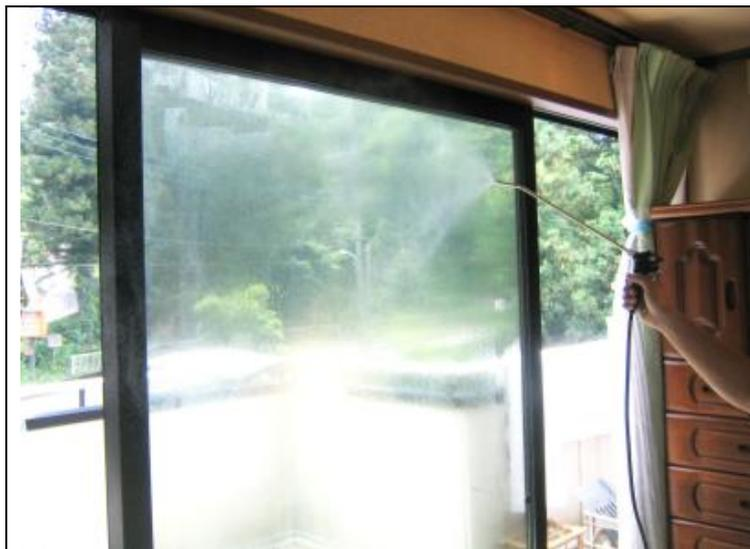
サッシュ、ガラス、シールの状態確認後、各所養生し、洗淨液をガラスに多めに噴霧します。
