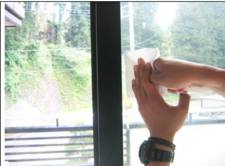
端部はヘラにペーパータオルを当て圧着します。吐き出した水を吸収し水の戻りが少なくなります。
