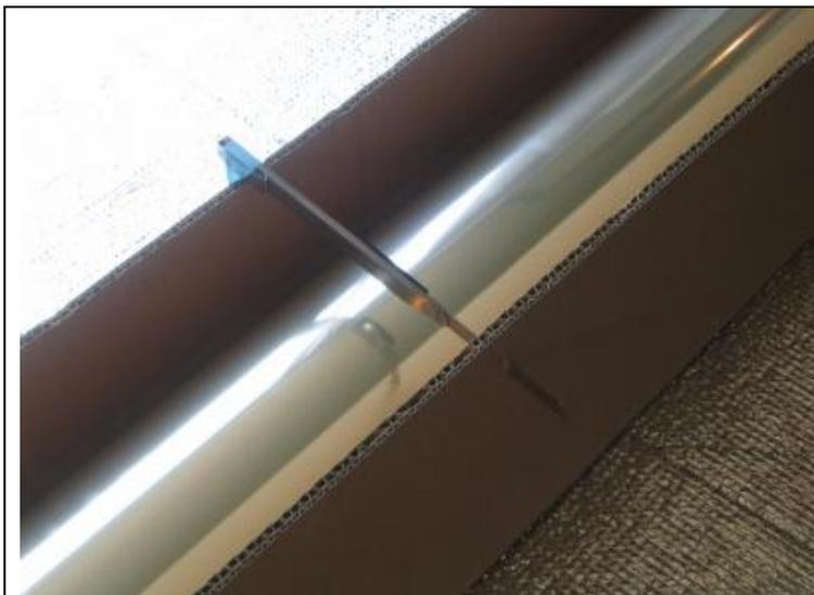
フィルム本体に糊が塗りつけてあり、これを剥離紙でカバーしています（ライナー）。従って箱から取り出した状態では2層（見かけ上）になっており、通常はロールの芯方向（巻き癖の内側）が接着面ですので間違えないようにご注意ください。断裁方法は 箱切りを基本とする。まず所定の位置にカッターを設置する。カッターがぐらつかない様に注意してください。
