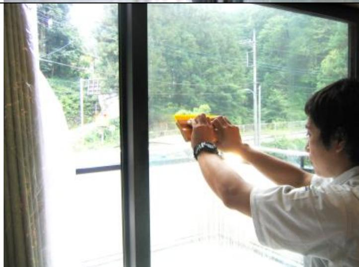
圧着はフィルムの表面にスプレーし20～30mm間隔で丁寧に上から下へ、真ん中から外側へゴムスキージーを押しながら水を抜きます。
