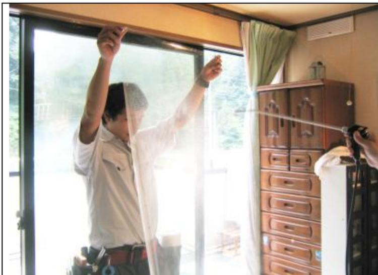
一度清掃しても空気中の塵埃が再び間隙に付着している場合がありますので、もう一度洗浄液をスプレーし、上から下へ埃を洗い落とします。
