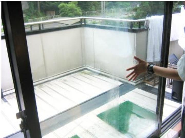
1. 大きなガラス面に貼り付ける場合は、フィルムを付き合わせる必要があります。この場合、重ね貼りをしないで、1mm程度の隙間を開け水の吐き出し口を作ってください。
