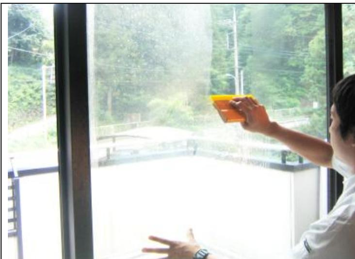
フィルムを滑らせながら位置を決め、フィルムの表面をスプレーし、ゴムスキージーで上部から真ん中にかけて押しながら仮止めします。
