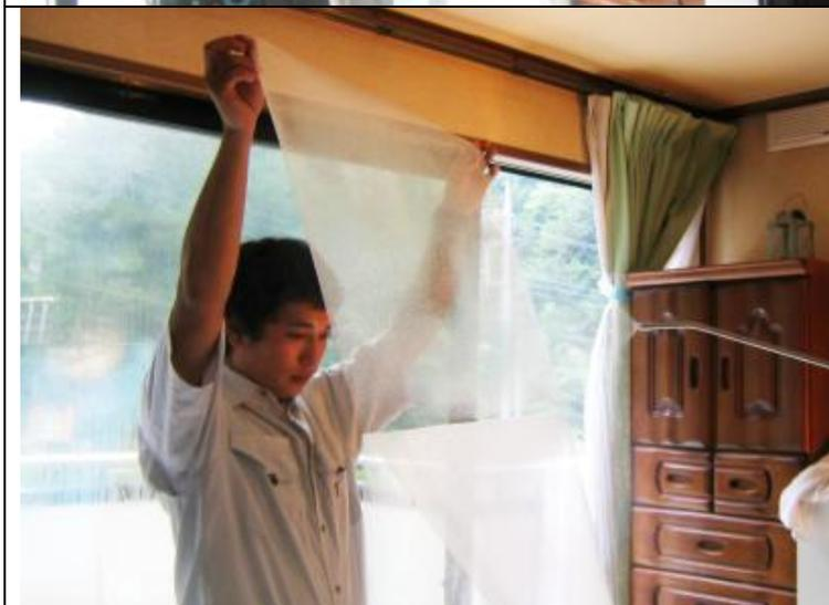
一人がフィルムを持ち、もう一人がセパレーターを剥がしながら粘着面に施工液をムラなく噴霧します。この際異物混入を防ぐ為、接着面をスプレーしながら剥がします。
