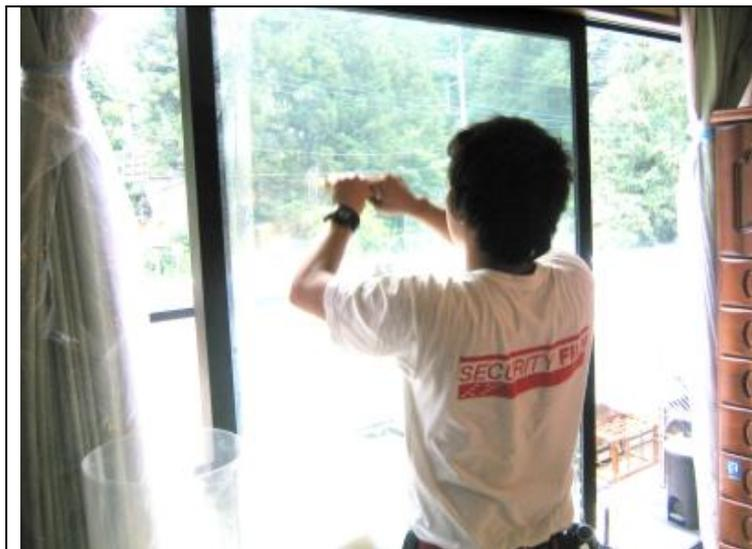
フィルム自体の腰が強いためスキージー・ヘラの力が、薄いフィルムより伝わり難く、貼り付け時の水分が残りやすくなります。
